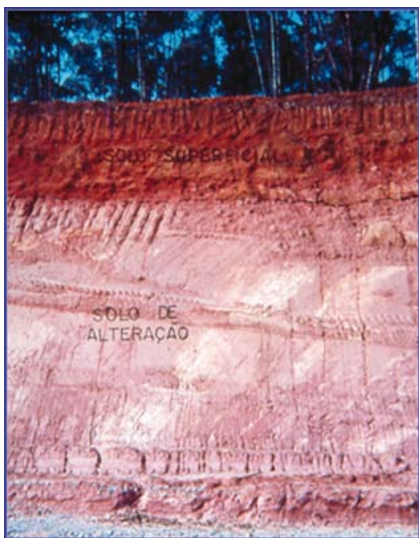
Figura 2.5.7.a – Camada de solo superficial (mais escura) e de solo de alteração (mais clara) em rochas sedimentares Terciárias. Fonte: Erosão e Assoreamento na RMSP – palestra apresentada pelo Geólogo Álvaro Rodrigues dos Santos, Guarulhos, 2005.
