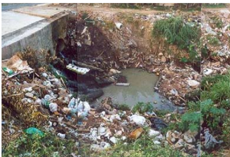
Figura 1.2.4 – Córrego com despejo de lixo. Fonte: Secretaria de Obras e Serviços Públicos de Guarulhos
