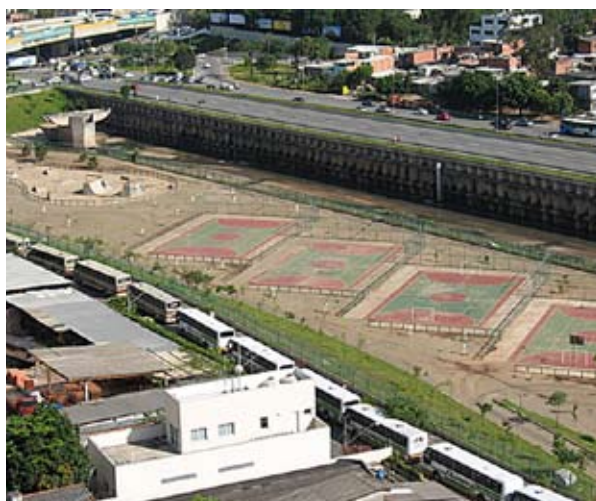
Figura 1.2.3.b – Foto de um reservatório de amortecimento de cheias (piscinão) na cidade de São Paulo, Av. Águas Espreiadas. Fonte: www.panoramio.com/photos/722317.jpg e www.panoramio.com/photos/original/729175.jpg – Acessado em 25/07/08.
