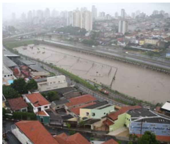
Figura 1.2.3.b – Foto de um reservatório de amortecimento de cheias (piscinão) na cidade de São Paulo, Av. Águas Espreiadas. Fonte: www.panoramio.com/photos/722317.jpg e www.panoramio.com/photos/original/729175.jpg – Acessado em 25/07/08.
